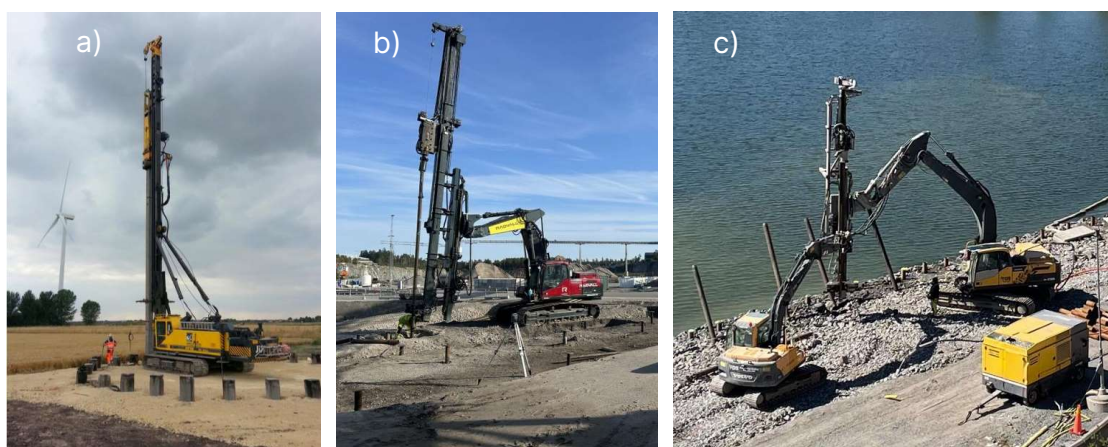
Figur 1. a) Slagning av betongpålar, b) Slagning av stålplålar, c) Installation av borrade stålplålar. (Foto: Anders Beijer-Lundberg)
